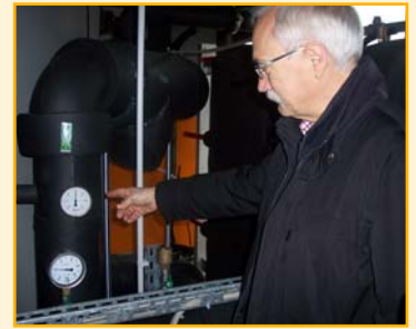
Überwachung von Druck und Temperatur im Kreislauf.
