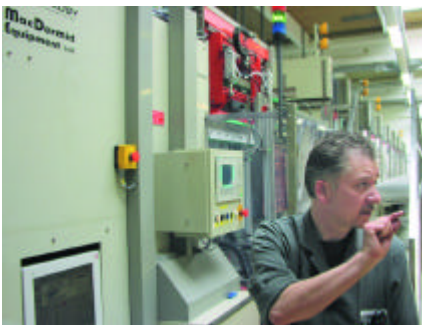
Eingabe- und Kontrollstation der vertikalen Durchlaufgalvanik
