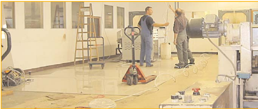
Baustelle: Das Instandhaltungsteam ist bei Umbaumaßnahmen besonders gefordert
