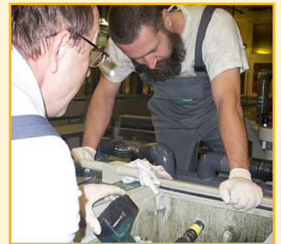
Handarbeit für das Instandsetzungsteam bei der Montage der neuen Module.
