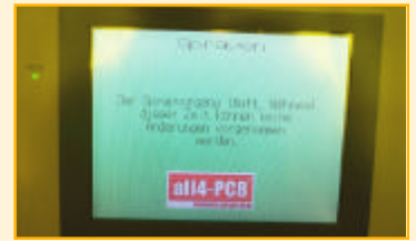
Das Bediendisplay für die Sprühanlage
